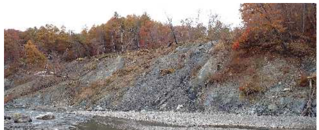
写真-3 岩知志地すべり末端部
