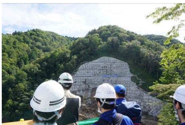
写真-3 三笠ぼんべつダムお立ち台から左岸施工状況を望む
