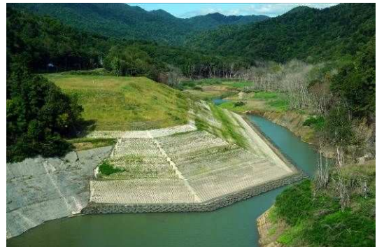
写真-3 貯水池地すべり 1-5 ブロック対策の押さえ盛土
