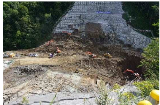
写真-2 三笠ぼんべつダム 堤体基礎岩盤の掘削状況
