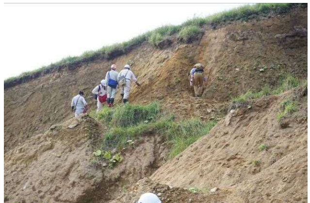
写真-3 串内牧場崩壊地
