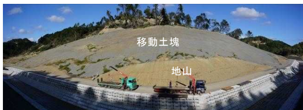
写真-6 地すべり末端部切土法面全景
