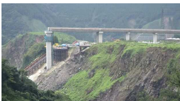
写真-1(上):新阿蘇大橋河川横断部の下部工施工状況 深い谷での施工で両岸から巨大なインクラインが稼働中。
