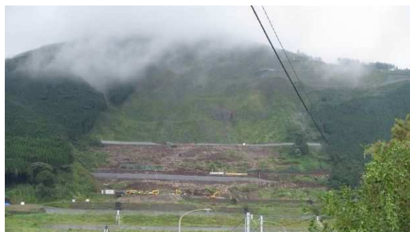
写真-3:大規模崩壊地
