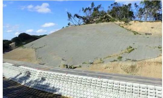
写真-2 河道閉塞部の切土法面
