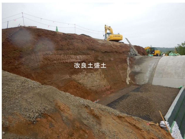
写真-1 忍路地区地すべり対策工施工状況
