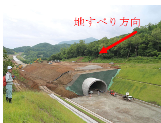
写真-1 忍路地区の地すべり
