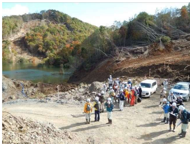
写真-4 河道閉塞を観察する様子 (10月18日撮影、厚真町日高幌内川)
