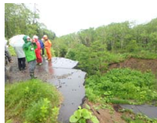
写真-3 道路側の状況
