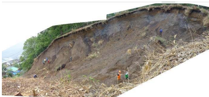
写真-2 滑落崖確認状況
