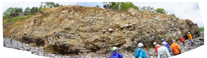
写真-7 幌萌地すべり 隆起体末端部
