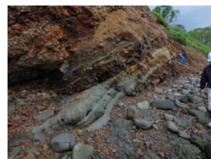
写真-5 露出した泥岩
