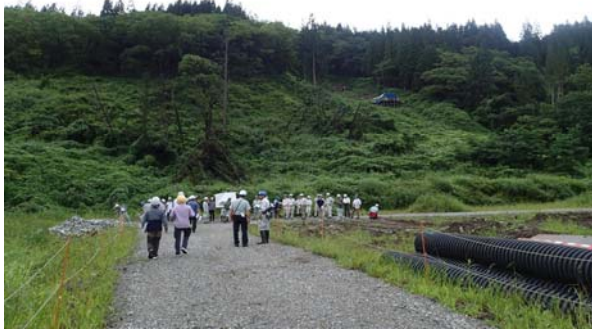
写真-3 八方岩地すべり末端部
