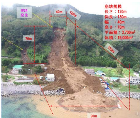
写真-1 海岸町地区 崩壊直後の状況
