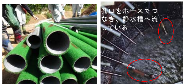
写真-2 目詰まり対策(左：植毛パイプ、右：酸素遮断策)
