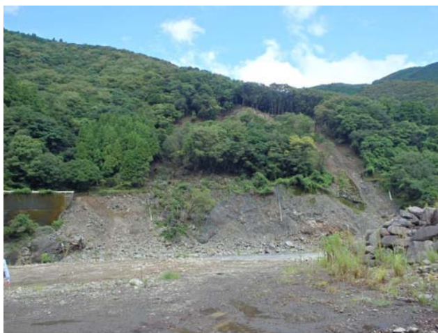
小島地すべり全景
