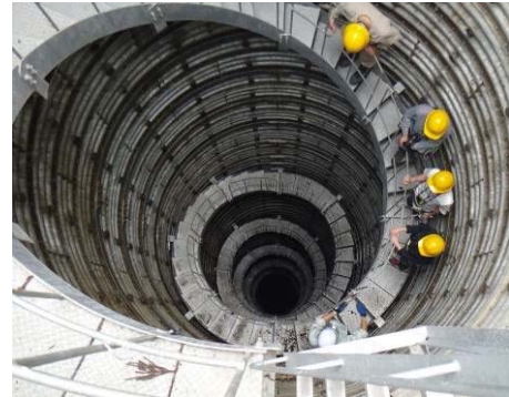
写真-2 深度 109m の集水井見学
