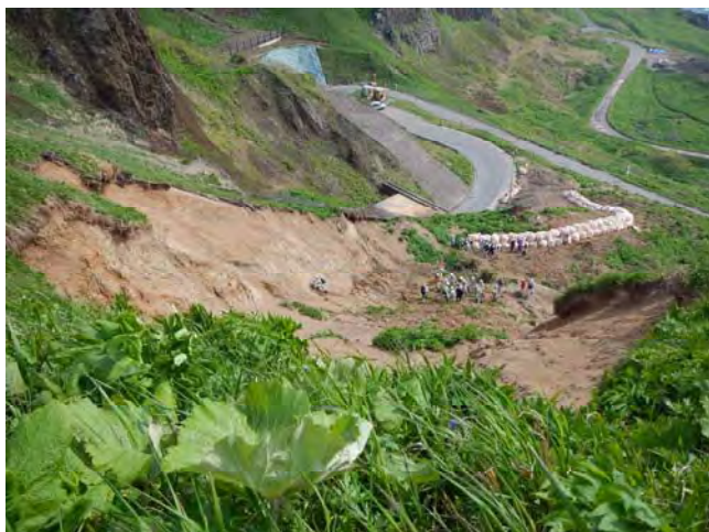
写真-1 桃岩トンネルで発生した斜面崩壊
