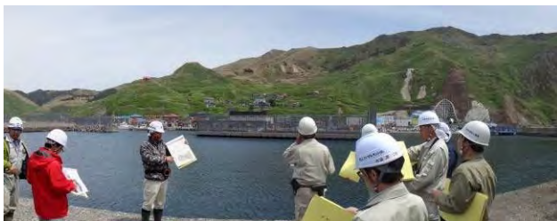
写真-8 元地漁港周辺の地すべりを防波堤より遠望
