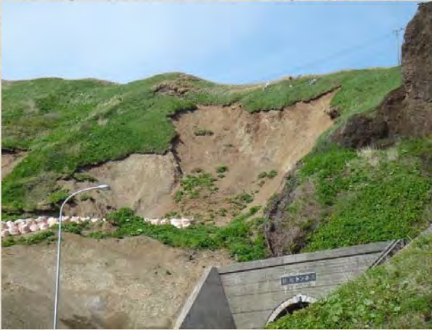
2-8 桃岩トンネル崩壊箇所での現地見学会の様子(1)
