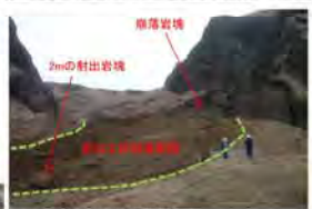
写真4: 2006年5月撮影 射出土砂の状況(射出源から約100m)
