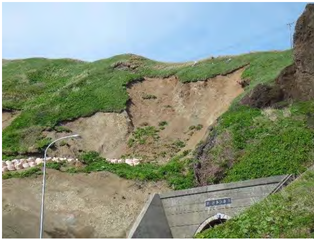
写真-11 桃岩トンネル元地側坑口で発生した崩壊
