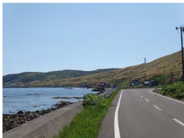
写真-2 東海岸沿いの崖斜面
