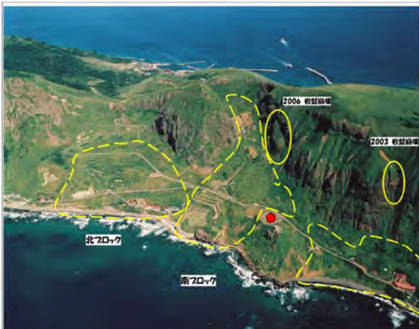
写真 3 1990 (平成 2) 年の地すべり対策が終了した元地地すべり 北ブロックは落ち着いている。南ブロックは押え盛土工と頭部切土工が完了した。 この写真には、2003 年および 2006 年の崩壊岩塊が写っている。
