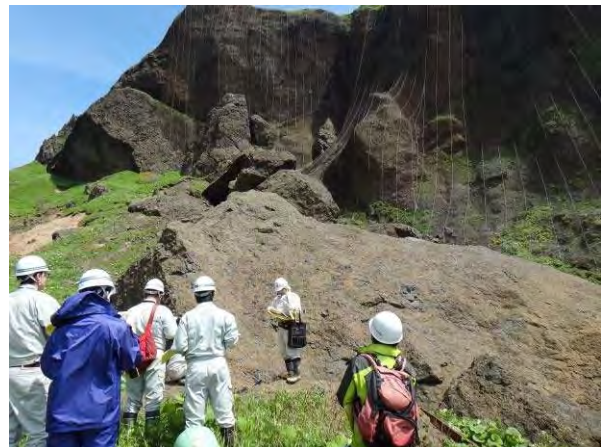
写真-9 射出を生じた崩落岩塊と崩壊発生源
