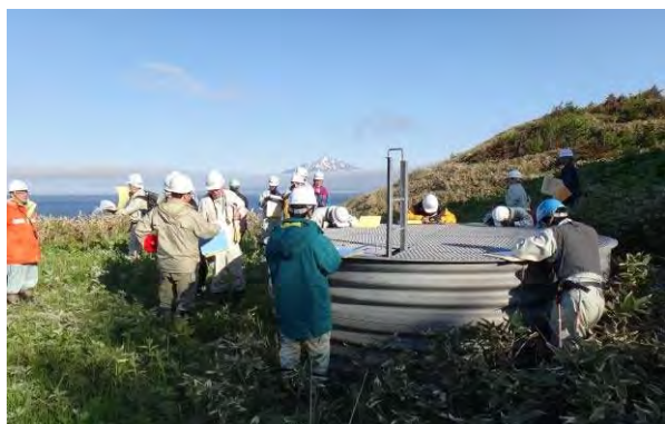
写真-4 手然地区の集水井施工状況を観察
