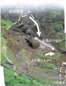
写真3: 2006年5月撮影 岩壁崩壊状況
