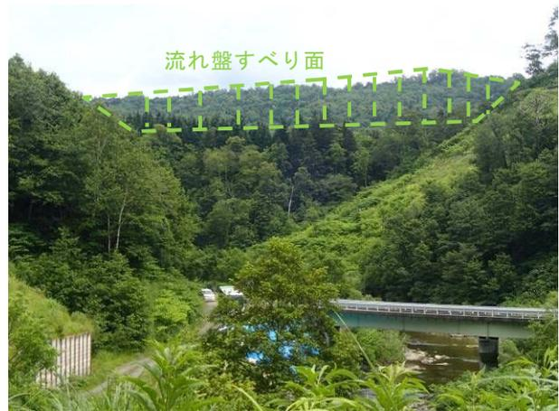
写真-2 流れ盤すべり面と移動土塊
