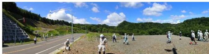
図- 3 地すべり(写真左奥), 国道(写真左), 押え盛土(写真中央から右)
