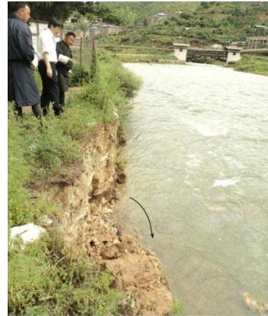
写真 7. 河岸の浸食状況 (比高 3m の河岸段丘)
