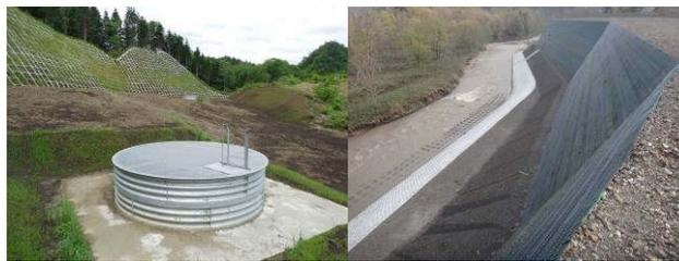
写真－6 集水井工（左）と押しえ盛土工（右）
