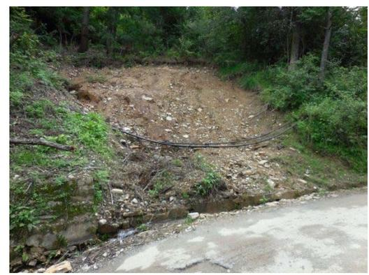
写真 6. 表層崩壊 (勾配緩い・降雨後)
