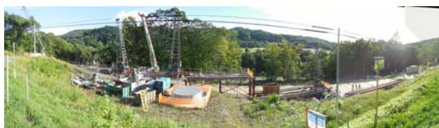
写真－5 対策工施工の様子
