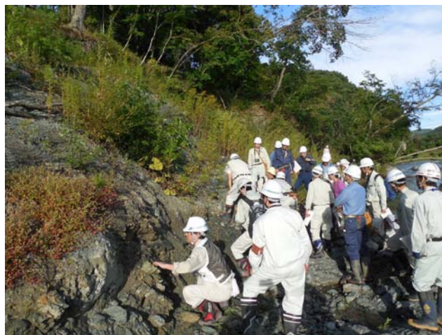
写真－7 地すべり末端部の浸食崩壊面にて
