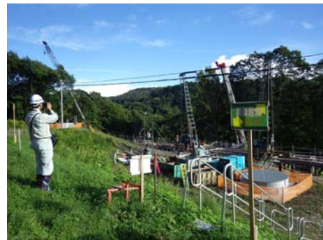
写真-3 施工中の集水井
