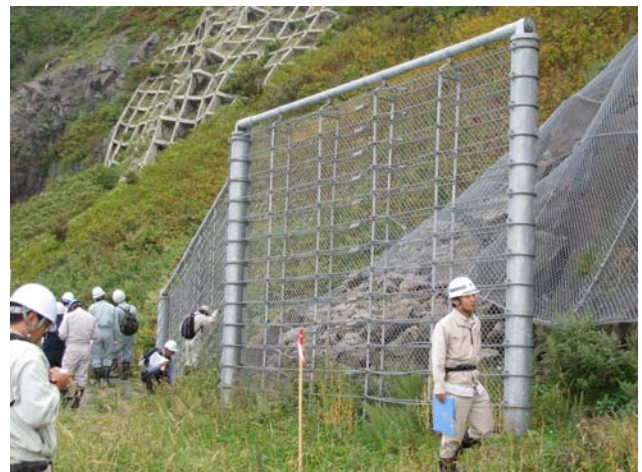
写真－6 高エネルギー吸収型の防護工 (仮設対策工の一部)
