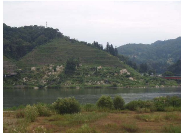
写真-2 妙見地区全景（H21. 8. 28 撮影）
