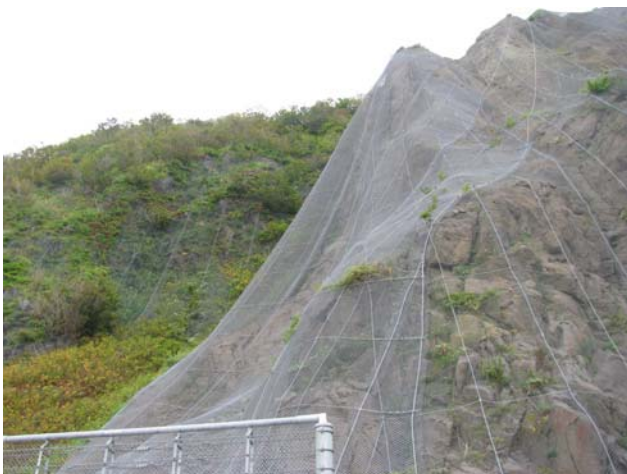
写真－4 増毛町岩尾岩盤崩壊面の現在の様子
