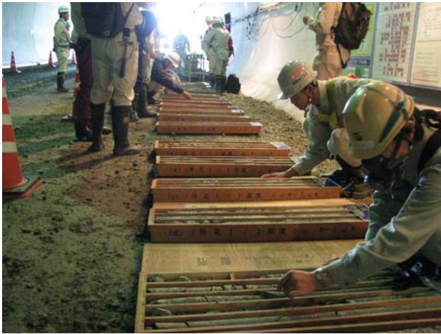
写真－3 先進ボーリングコアの観察の様子
