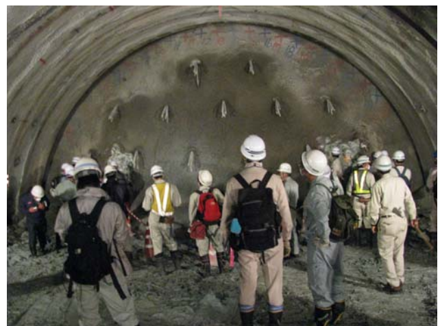
写真-2 開放された切羽面の蛇紋岩を観察する様子 (部分的に 2 箇所開放)
