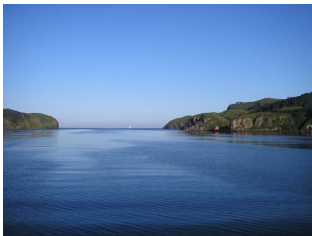
写真-5 朝の穴澗湾口-岩盤崩壊跡がみえる
